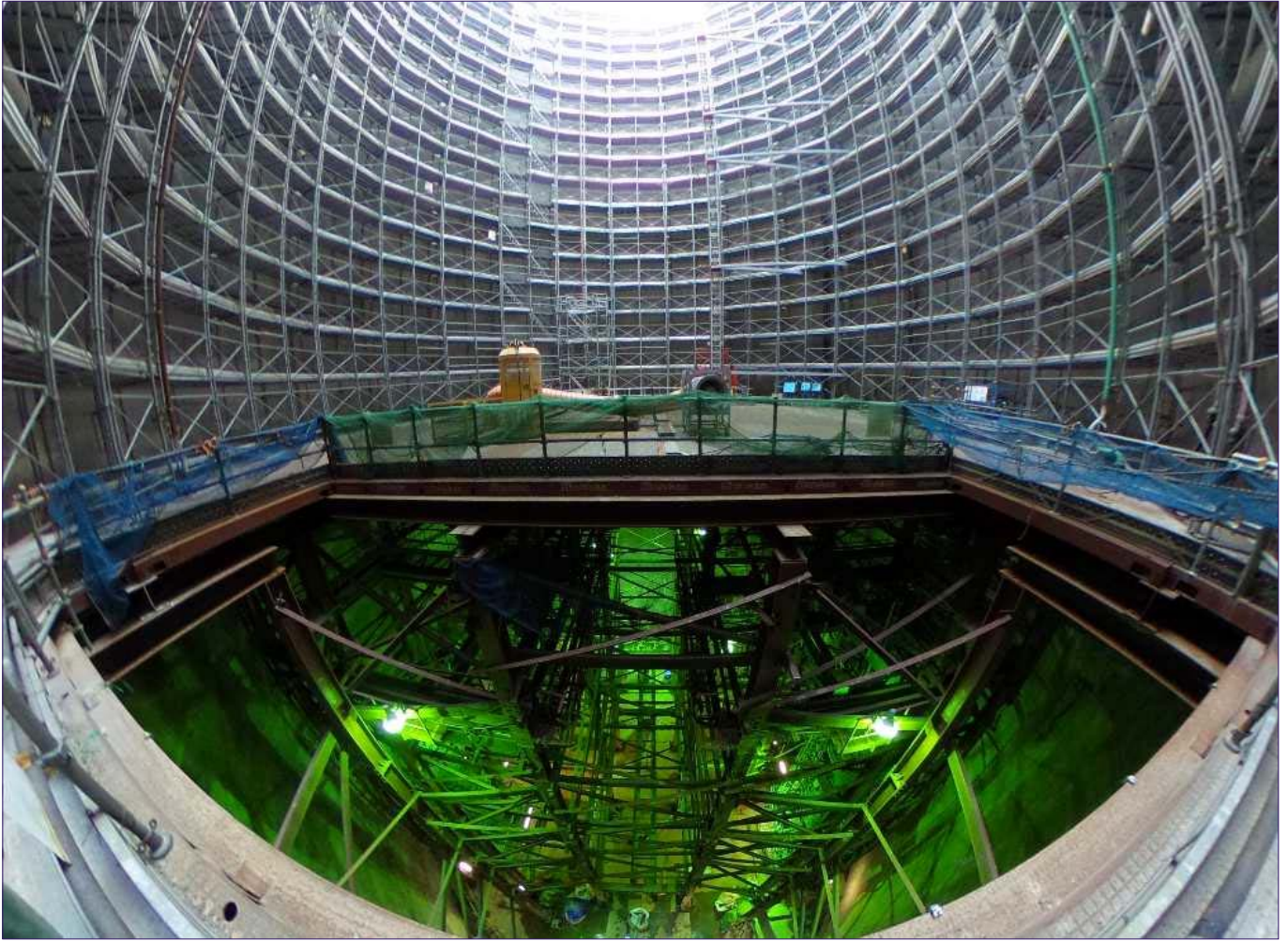
鋼殻ケーソン (鋼殻は台船で曳航)
