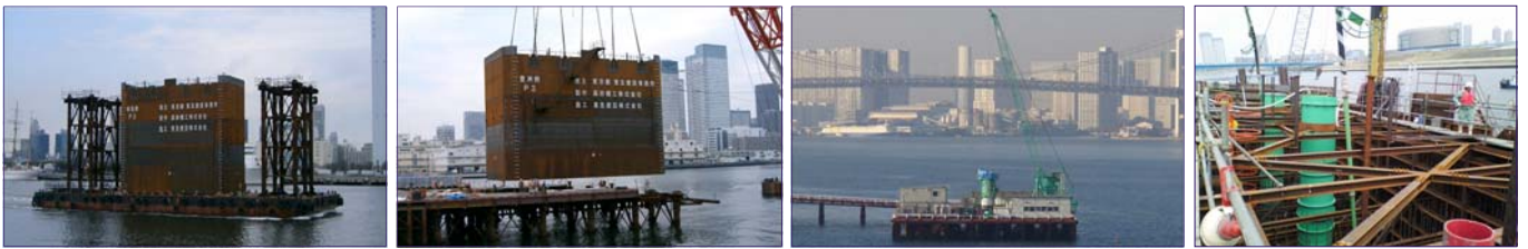
鋼殻ケーソン (鋼殻は台船で曳航)
