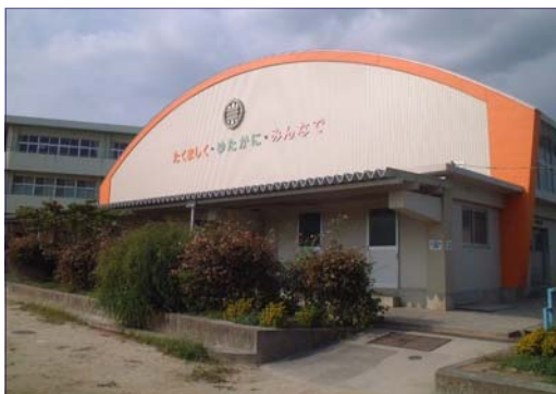
小学校屋内運動場
