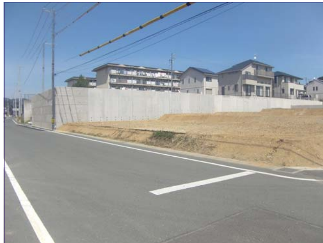
擁壁（区画整理事業）新設工事
