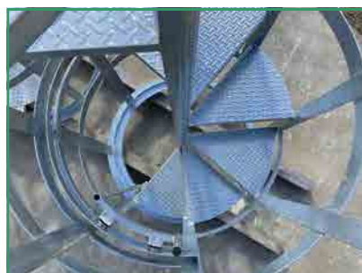
下部縞鋼板引き出し式踊り場付き螺旋階段
