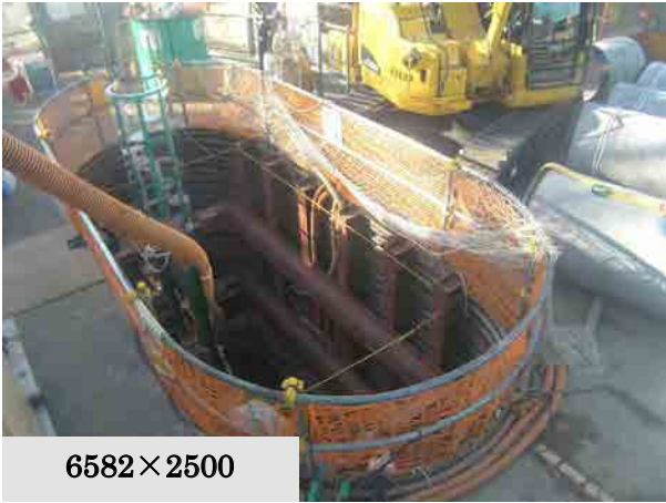
発進立坑（ライナープレート・鋼製ケーシング）
