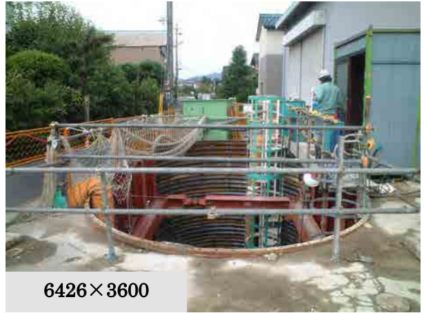
発進立坑（ライナープレート・鋼製ケーシング）
