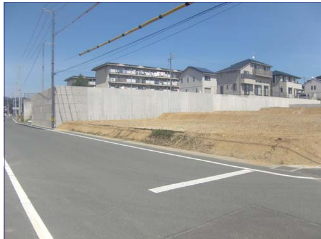
擁壁（区画整理事業）新設工事
