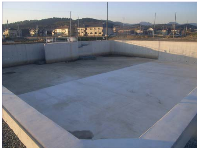
雨水調整池工事
