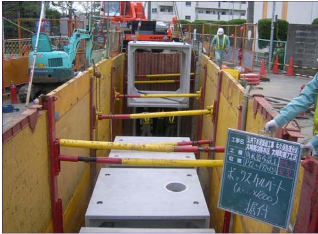
開削 (□1800 ボックスカルバート)
