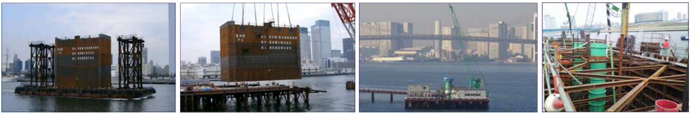
鋼殻ケーソン (鋼殻は台船で曳航)
