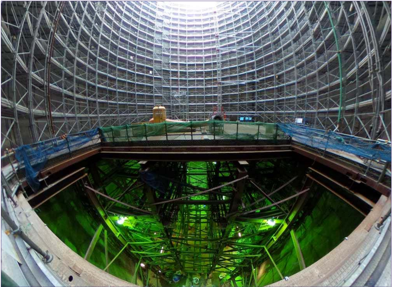
鋼殻ケーソン (鋼殻は台船で曳航)
