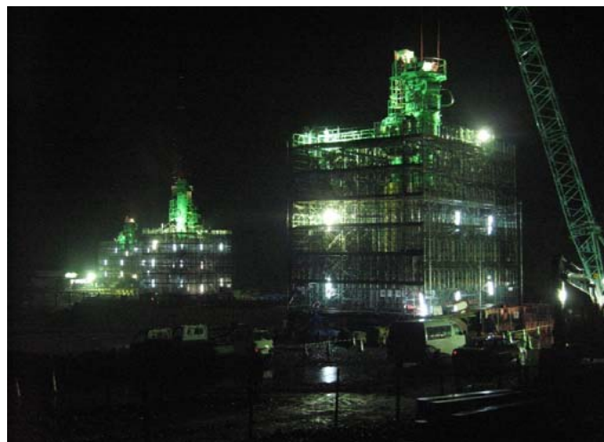
ピアケーソン(0.3Mpa 同時施工)
