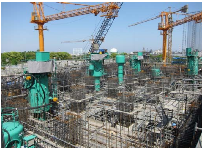
浄化センター
