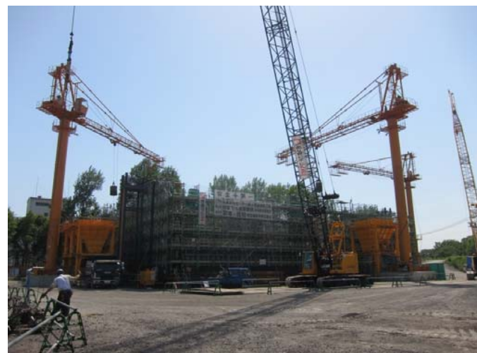
浄化センター2
