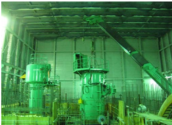
放水路（シールド発進立坑）
