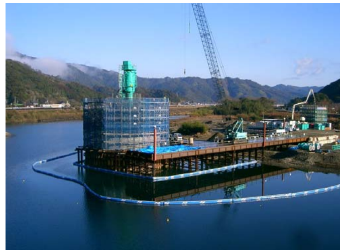
ピアケーソン（橋脚）
